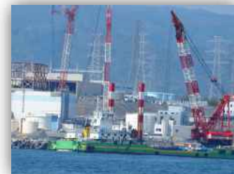
2022年4月25日工事着工の様子 東京電力福島第一原発 写真：たらちね
